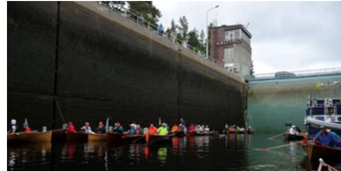
Die Schleuse in Kaltimo
