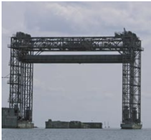
Die Reste der Eisenbahnbrücke Karnin
