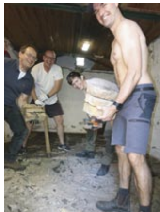
Die Abbruch-Crew: Kai, Jens-Peter, Moritz & Christian (v.l.n.r.) dürfen was kaputtmachen.
